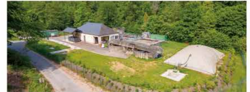
solution enterrée de biométhanisation au sein de la brasserie Orval
