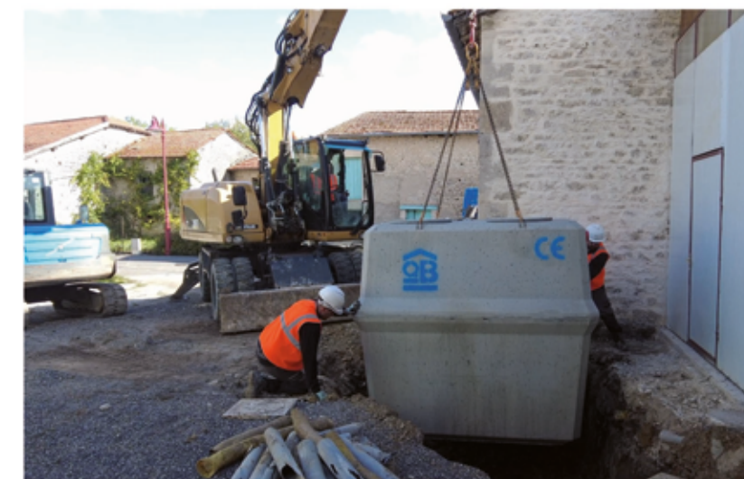
Pose d'une micro-station oxyfix® 5EH sous allée de garage
