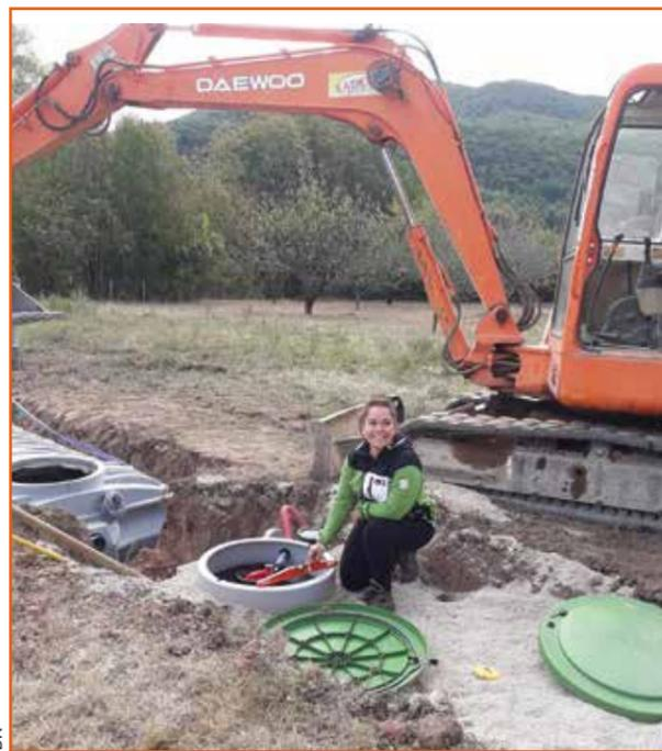
Lors du contrôle de réalisation, un niveau permet de vérifier l'horizontalité des ouvrages.
