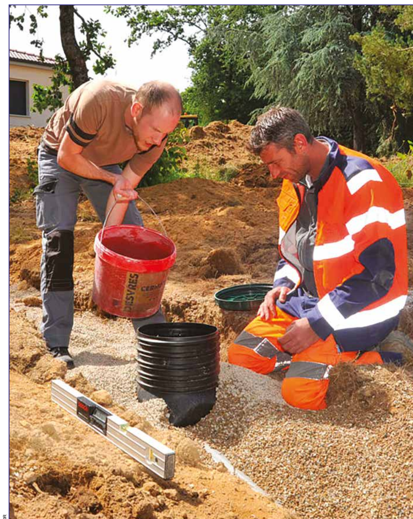
Phase ultime des travaux, le remblaiement est une opération délicate mais essentielle pour garantir la pérennité de l'ouvrage dans le temps. Une des missions du Spanc est de contrôler que les prescriptions des fabricants auront bien été respectées par l'entreprise de travaux.
