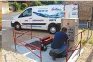
Postes de relevage
