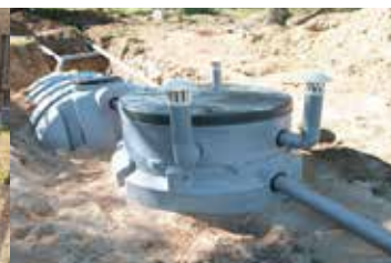
Microstations d'épuration
