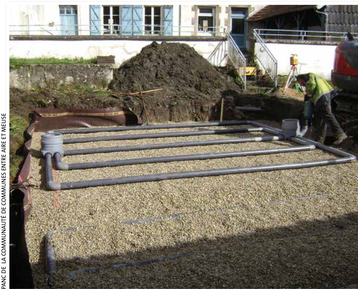
Le particulier règle 20 % de sa participation lors du piquetage, 50 % à réception des travaux, 30 % lorsque l'ensemble de l'opération groupée se termine.
