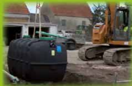
Pose de la fosse
