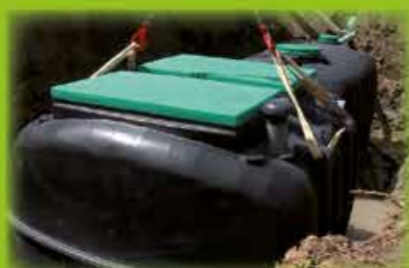
Pose du filtre
