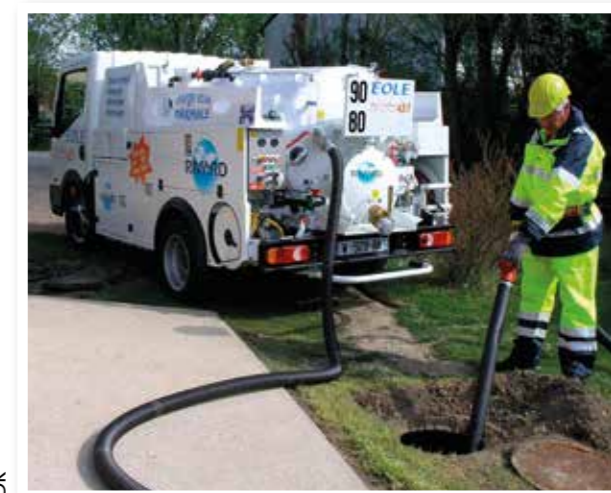
Les hydrocureurs doivent être garés à une certaine distance du dispositif d'ANC pour garantir les performances de pompage et la stabilité de l'ouvrage.
