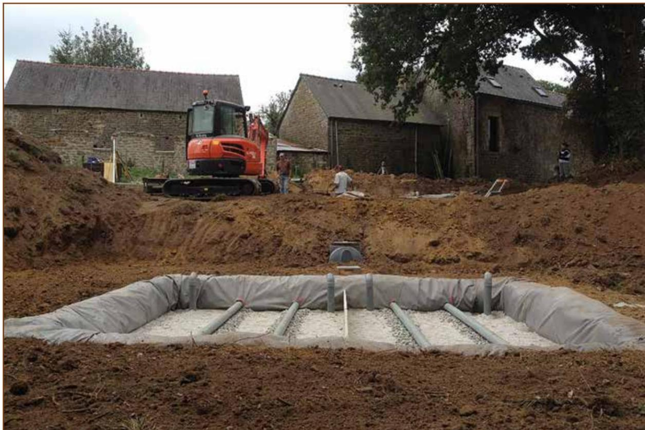
Lors du remblaiement de la filière de traitement, il est déconseillé de compacter la terre avec la pelle mécanique au-dessus des canalisations pour éviter de déformer les tuyaux ou de les déplacer.
