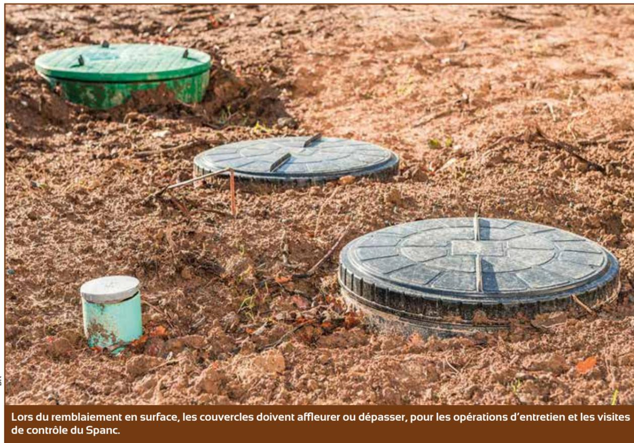
Lors du remblaiement en surface, les couvercles doivent affleurer ou dépasser, pour les opérations d'entretien et les visites de contrôle du Spanc.
