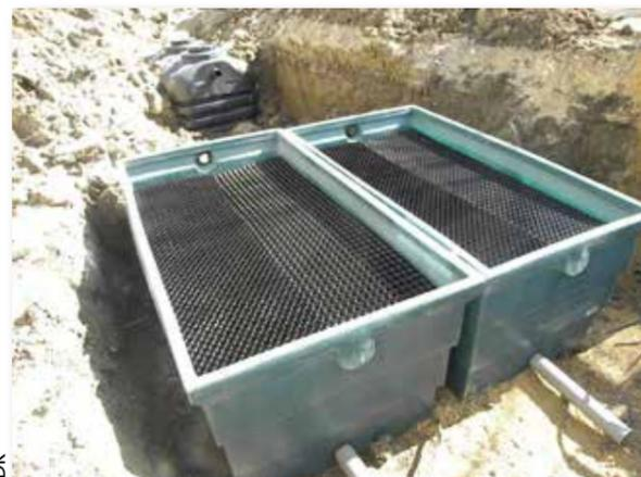
des filtres et un regard de bouclage en sortie. L'aération est assurée par deux cheminées de ventilation, l'une en entrée de filtre sur le drain de répartition, la seconde en fin de filtre, reliée au drain de collecte. Livré en kit, le dispositif se contente d'une surface d'implantation inférieure à 6 m<sup>2</sup>, ce qui offre une alternative intéressante aux filtres à sable qui nécessitent une surface minimale de 20 m<sup>2</sup>.
