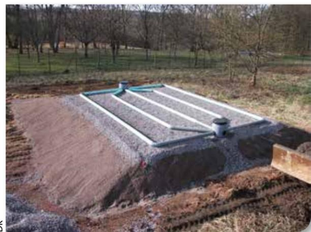
Un tertre est un dispositif de traitement traditionnel qui permet d'installer un ANC en présence d'une nappe haute ou d'un sol peu profond.
