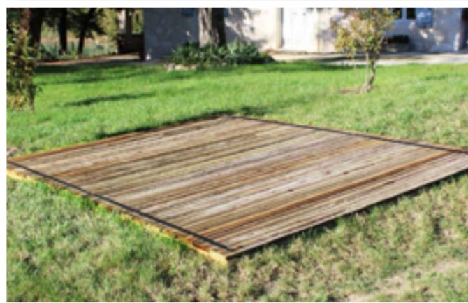
sa stabilisation. Les lombrics par leur déplacement permettent d'éviter tout colmatage. Ces lombrics, appelés aussi vers de fumier, sont des *Eisenia fetida* et des *Eisenia andrei* d'une longueur de 6 à 8 cm et de 5 mm de diamètre. Le système est dimensionné pour 5 EH. Le lombrifiltre doit être changé tous les ans, et le filtre usagé envoyé en centre de compostage agréé.
