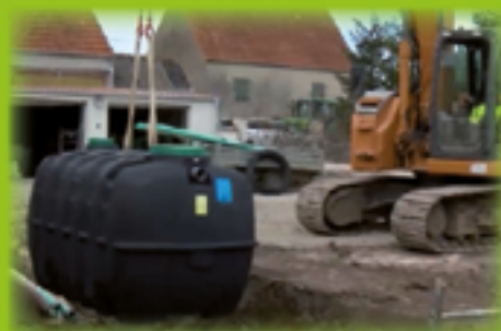
Pose de la fosse
