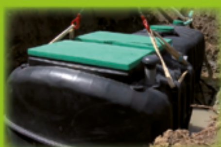
Pose du filtre
