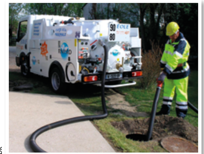
Les hydrocureurs doivent être garés à une certaine distance du dispositif d'ANC pour garantir les performances de pompage et la stabilité de l'ouvrage.
