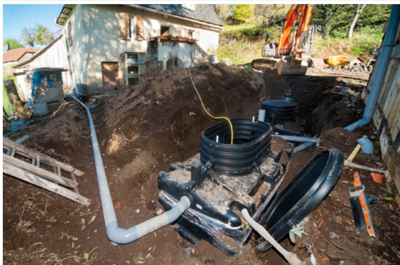
La collectivité a intérêt à prévenir l'utilisateur de l'ampleur des travaux sur sa parcelle bien en amont du lancement des opérations, pour éviter les surprises.
