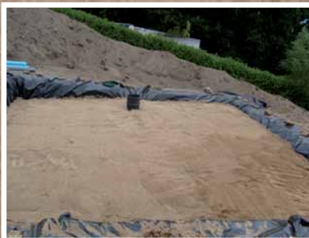
Étapes de la réalisation d'un filtre à sable drainé par Florient Martinaud.
