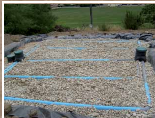
Étapes de la réalisation d'un filtre à sable drainé par Florient Martinaud.
