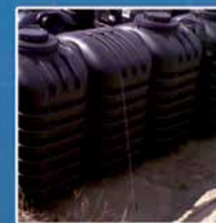
LES CUVES SONT FIXÉES AFIN D'ÉVITER TOUT MOUVEMENT
