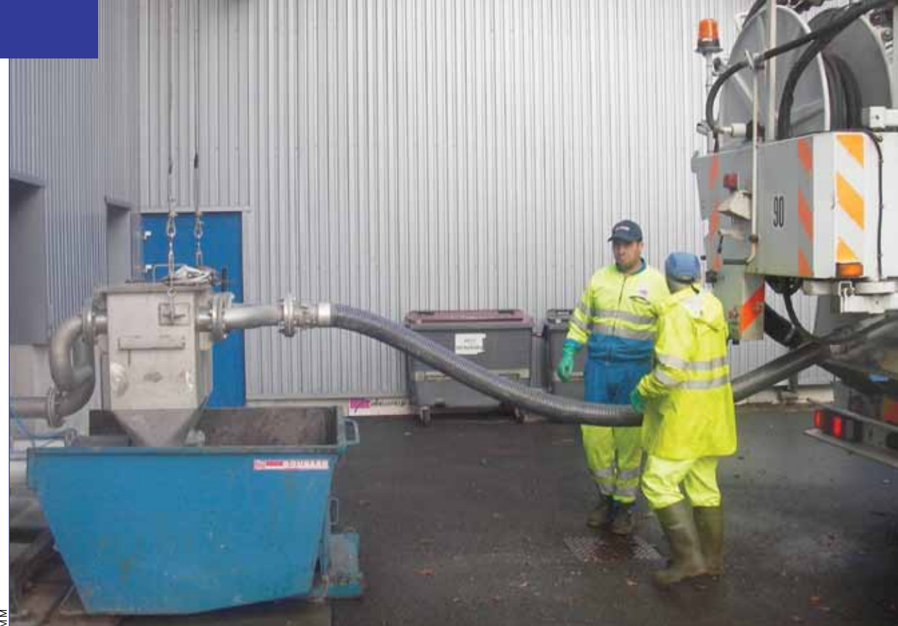
De plus en plus de stations d'épuration, comme ici à Dax, prélèvent des échantillons sur les matières acceptées et les conservent pour une éventuelle analyse a posteriori en cas de problème.
