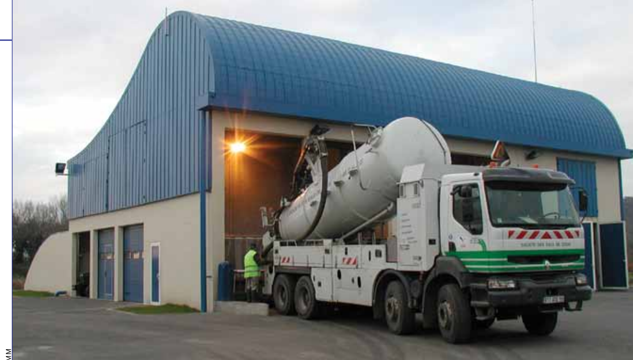
Le GIS Biostep recommande de prévoir l'aération de la bache de stockage qui permet d'étaler l'injection des matières de vidange dans les bassins de traitement (ici à Douai). Cette aération favorise le passage en aérobiose, relève le potentiel redox et permet un premier abattement de la DCO
