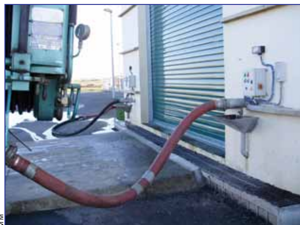
Des métaux lourds, des chlorures ou des hydrocarbures risquent de perturber le traitement ou de contaminer les boues. Les exploitants sont donc très vigilants sur l'origine des matières apportées en station (ici à Niort).
