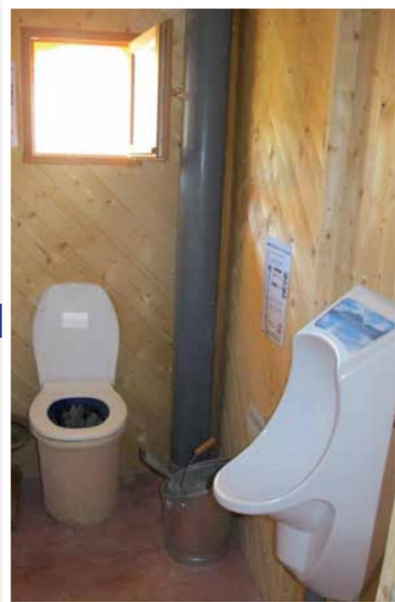
*Au fond, des toilettes sèches à compost, avec un seau de litière carbonée et une fenêtre d'aération. L'urinoir à droite peut servir de substitut à des toilettes à séparation. Mais pour les hommes seulement.*
