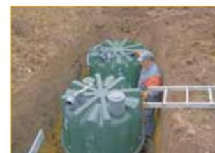
le plus petit se contente d'une cuve de prétraitement et d'une cuve de traitement à biomasse fixée. Cette dernière est divisée en quatre compartiments: le premier assure un brassage grâce à un diffuseur de microbulles; le deuxième et le troisième sont des réacteurs biologiques, également équipés d'un diffuseur; le dernier permet une décantation finale avant rejet; il est nettoyé chaque jour par une pompe de recirculation immergée. Les diffuseurs sont alimentés par un compres-
